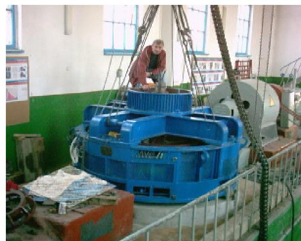
По центру кадра — вертикальный генератор ВГС-450-40-0,4 производства Электромаш, с прямым приводом от гидротурбины, а правее от него, установленные компанией «Новосвит» (г. Винница, Украина) — горизонтальный генератор Voith Siemens (Германия), с приводом от гидротурбины через угловые редукторы и со сложной ременной передачей на возбудитель, установленный отдельно
