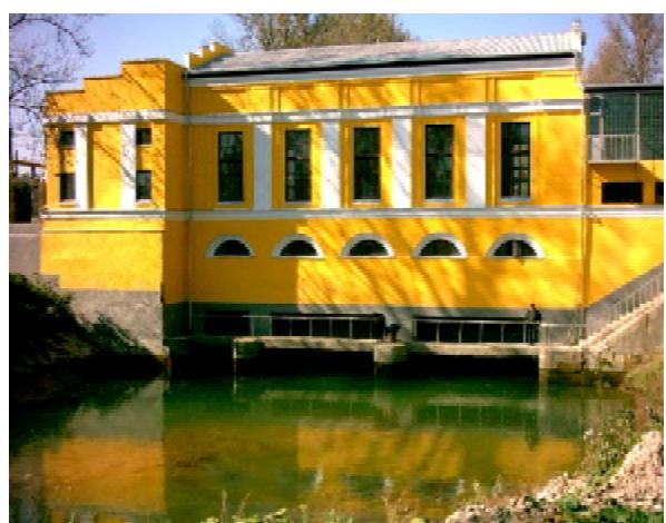
Данная миниГЭС (два гидроагрегата по 400 кВт) находится в г. Сняtin (Ивано-Франковская обл., Украина) на отводном канале от реки Прут, была введена в эксплуатацию в 1959 году, но позднее законсервирована — после постройки крупных ГЭС и АЭС, в связи с развитием единой энергосистемы СССР.
